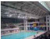
Vista interior estructura piscina cubierta. (Villa olímpica Atenas – Grecia) Foto arq. Agustín Garcia Puga ®
